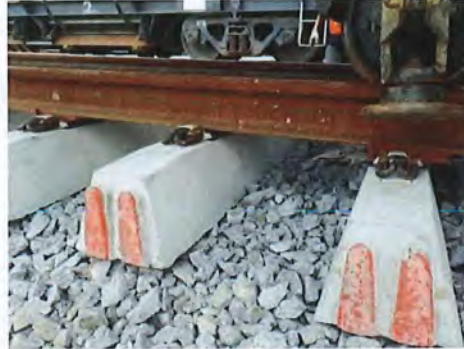
รูปแสดงการติดตั้ง Rail Taper Block
